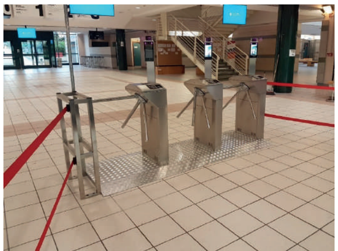
📍 I tornelli di controllo e tracciamento degli accessi
